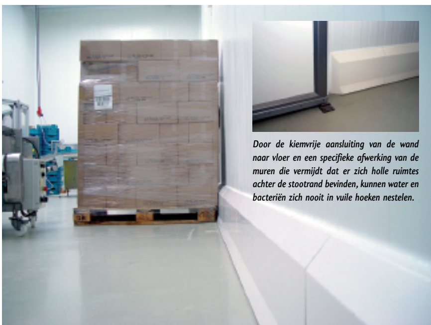
Didess koos voor de polyesterkwarts stootranden van PolySto, die met een gladde, onrotbare, herstelbare, foodsafe gelcoating zijn afgewerkt.
